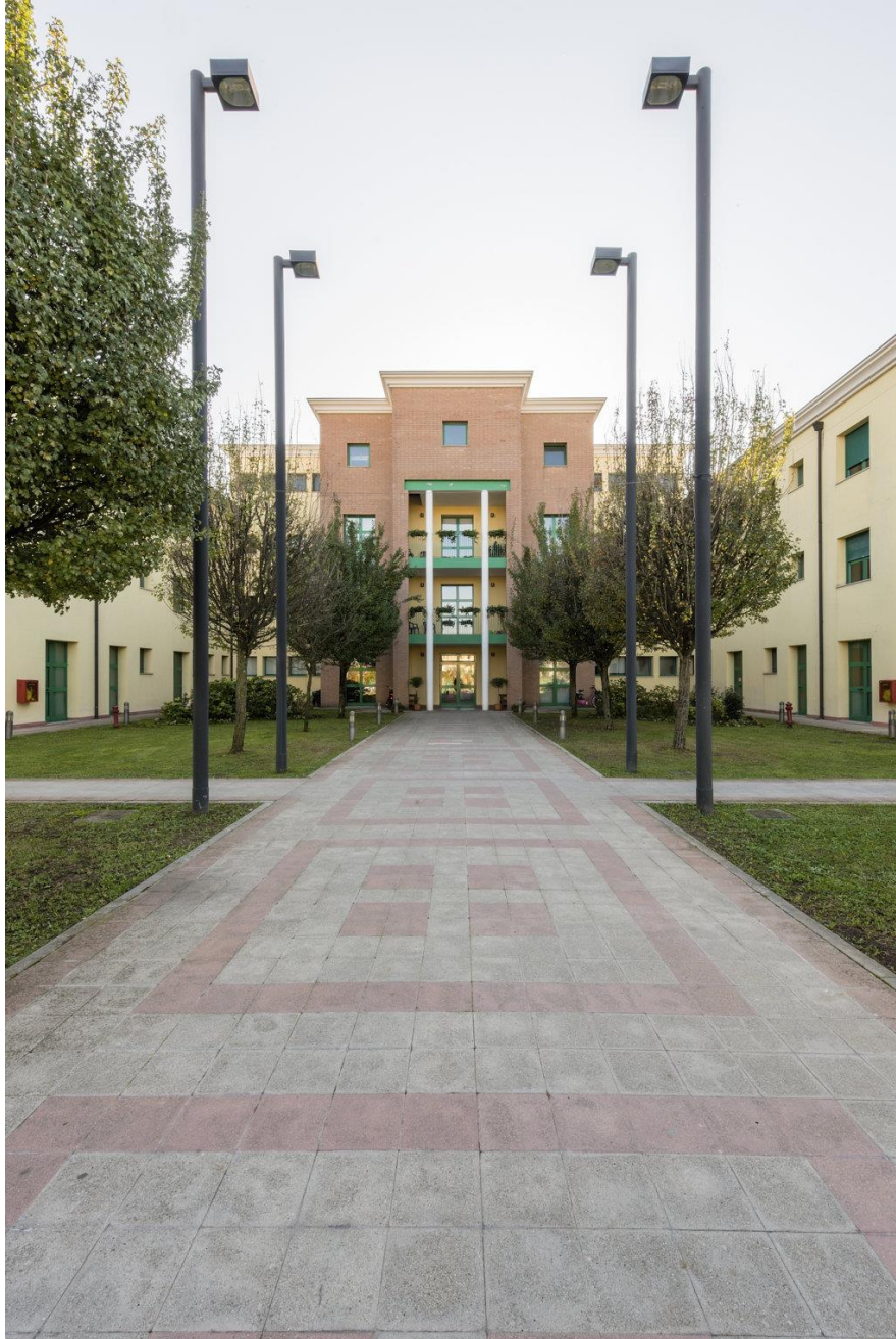
Vista dell'ingresso principale
